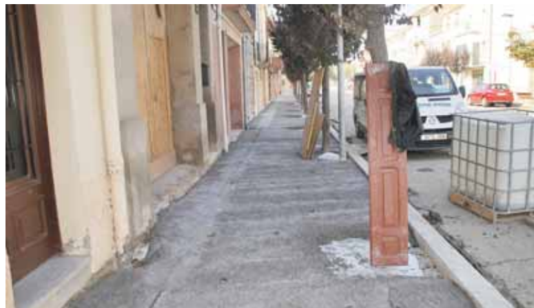
RENOVACIÓ DE VORERES
