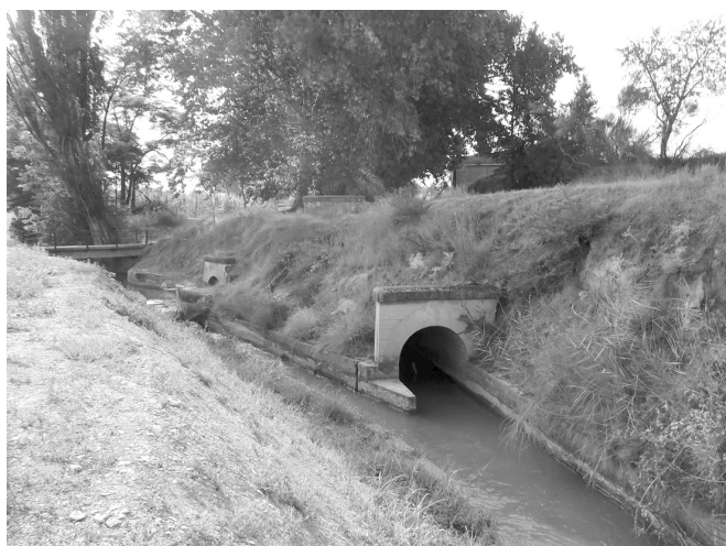
Desembocadura del Canal Auxiliar al Canal d'Urgell.
