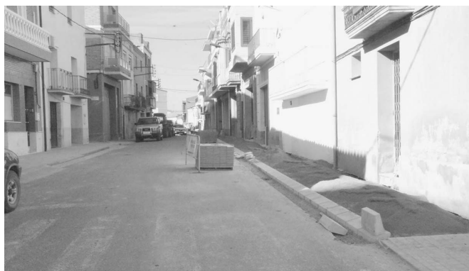
Treballs a la vorera del costat nord del carrer Nou.
