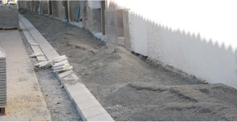
RENOVACIÓ DE VORERES
