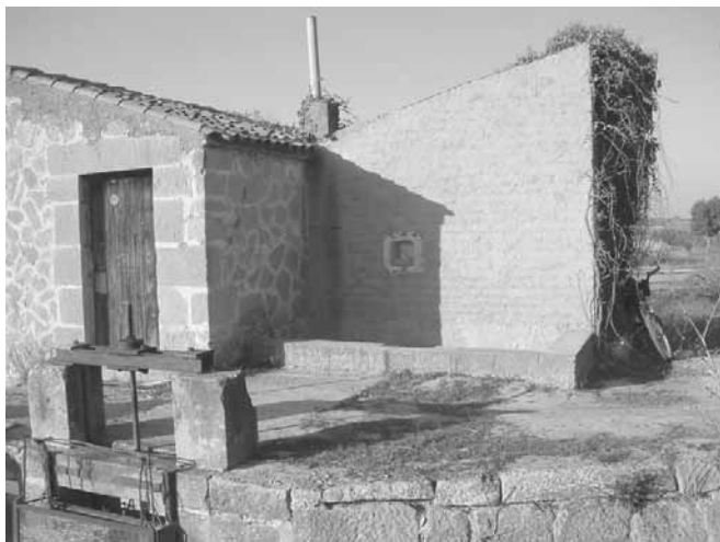
Comporta per enviar l'aigua a la turbina
