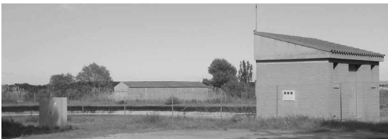
Bassa d'emmagatzematge d'aigua i caseta de les noves bombes
