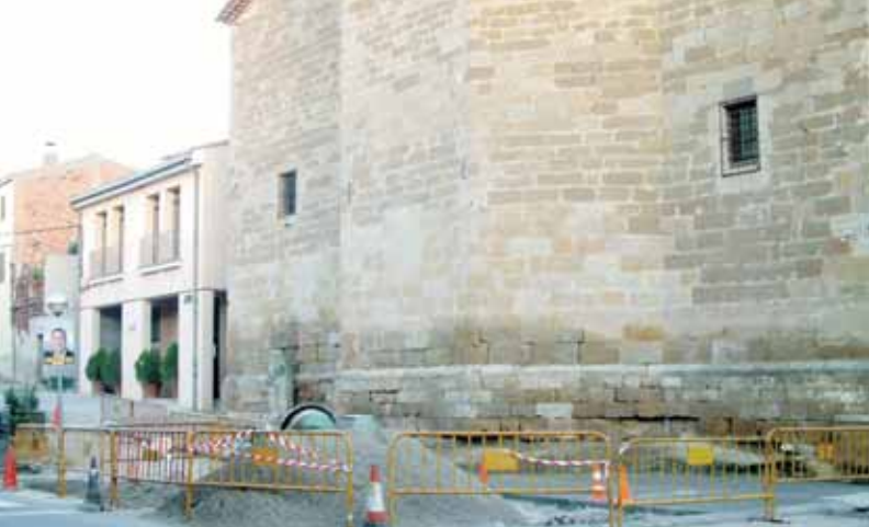
OBRES A LA PLAÇA MAJOR
