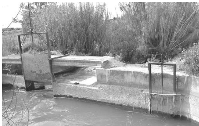
Comporta de la peixera, a la dreta pala de la sèquia Cadiereta.
