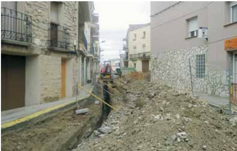
OBRES DEL CARRER NOU
