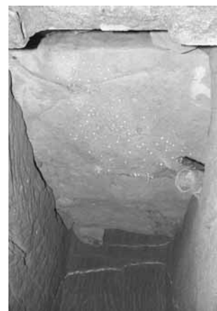
Mostra de l'enllosat primitiu de coberta
