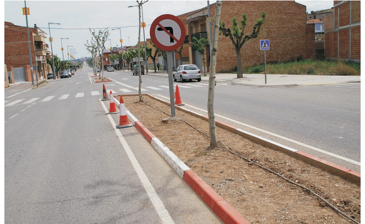
OBRES A LA MITJANA DE LA CARRETERA
