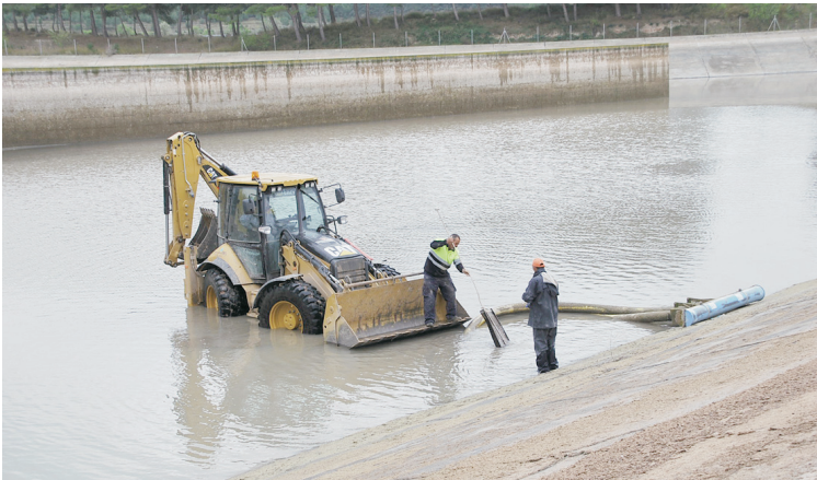
NETEJA DELS DIPÒSITS D'AIGUA POTABLE
