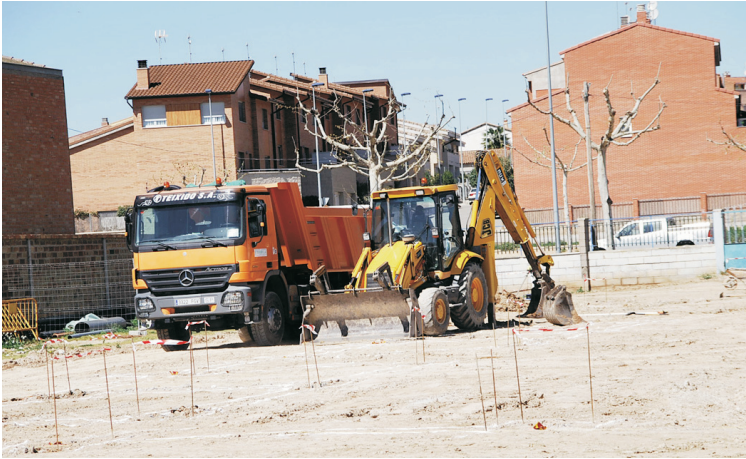
INICI D'OBRES DEL PAVELLÓ ESPORTIU
