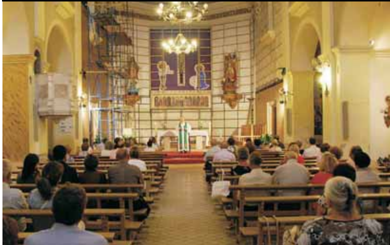
OBRES AL PRESBITERI DE L'ESGLÉSIA
