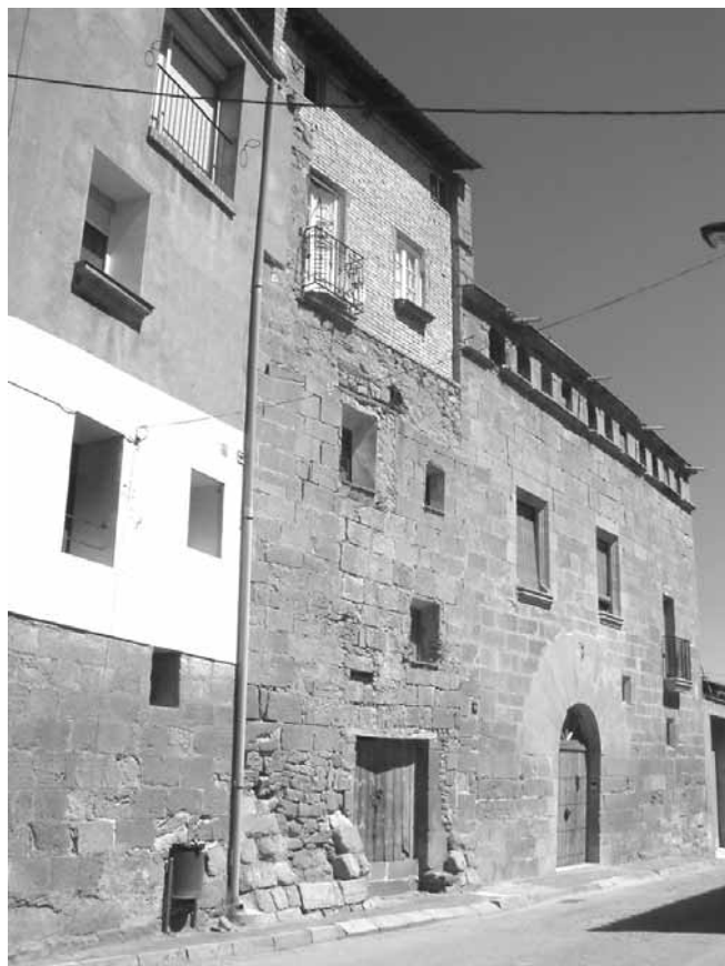
Foto 1. Vista de la torre (a la part central dela imatge)
