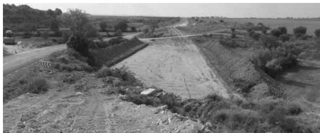
Les obres a la Comasala
