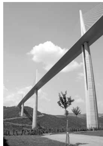
Viaducte de Millau (França)
