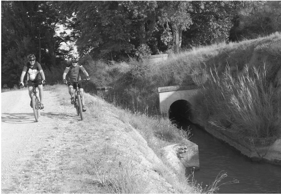
Zona de desguaç del canal Auxiliar al Canal d'Urgell al terme d'Artesa.
