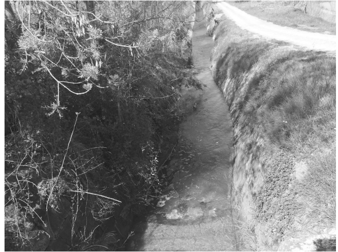
Canal d'Urgell i banqueteta al terme de Puigverd.
