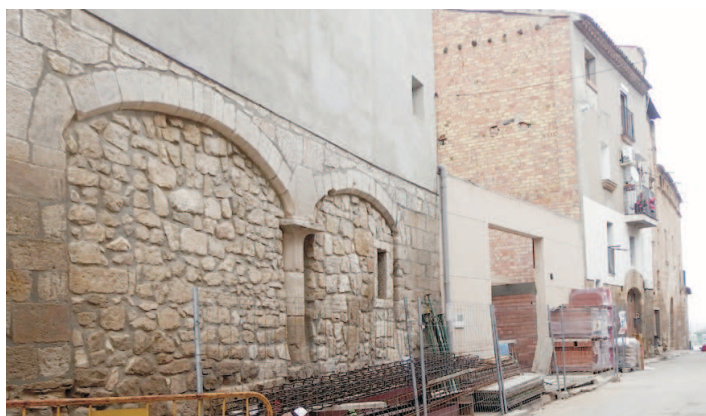
CONSTRUCCIÓ DEL MUSEU DE LES JOGUINES
