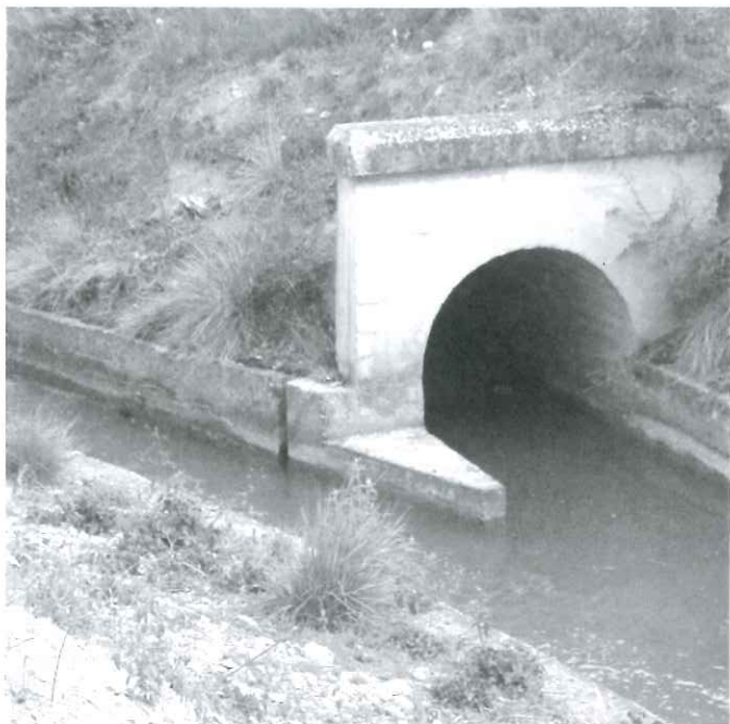
La nova connexió amb el canal d'Urgell
