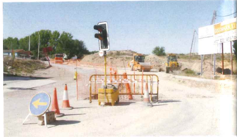
OBRES AL CARRER CASTELL
