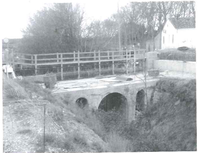
Obres al pont del Subcanal d'Urgell
