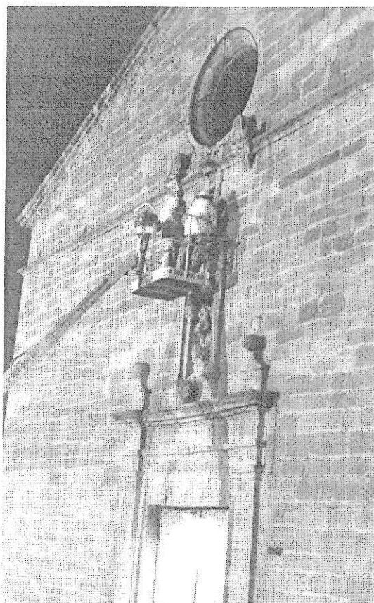
Obres a la façana de l'esglèsia
