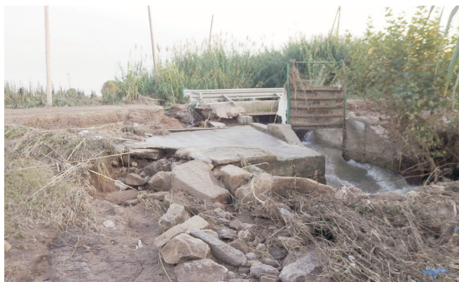
Efectes ade la riuada de La Femosa als ponts de les Fonts i de carrerada de Mulleu.
