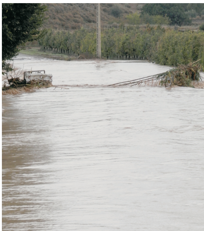
Detall del pont de camí de Castelló prop del molí.
