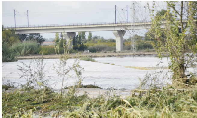
La Femosa al viaducte de la línia de TGV.
