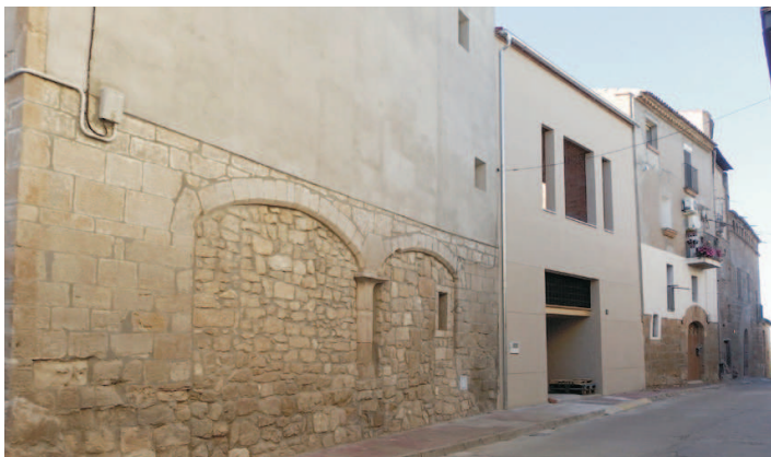
ACABADES LES OBRES DE LA 1ª FASE DEL MUSEU DE LA JOGUINA
