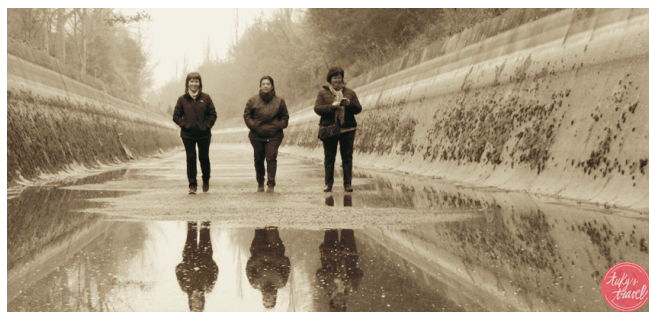
Túnel de Montclar.
