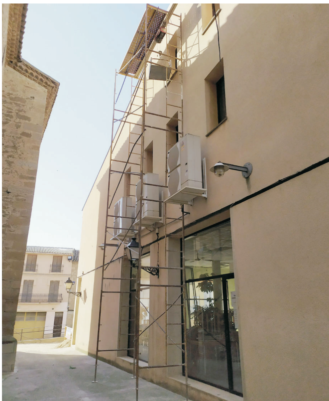
Obres del Centre de Serveis.
