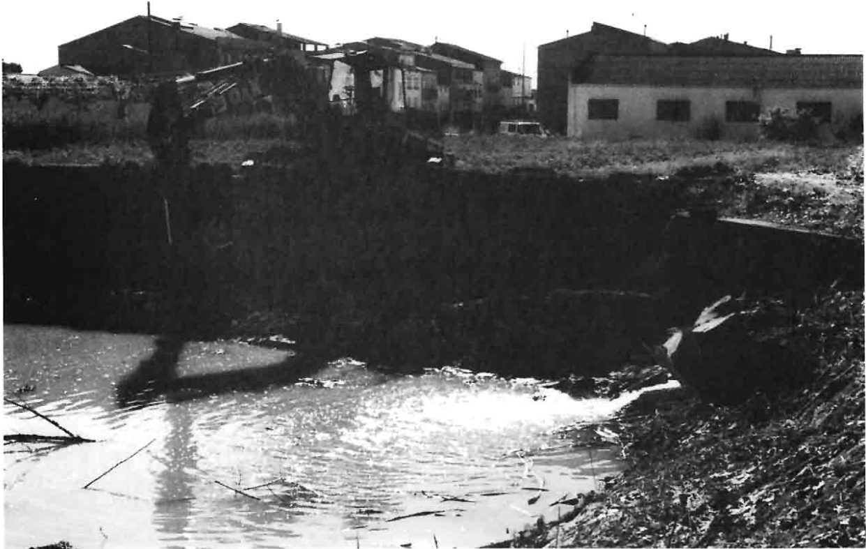
Màquina treballant en el marge que es va reforçar
