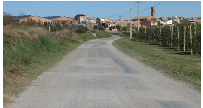
Reparació de clots
