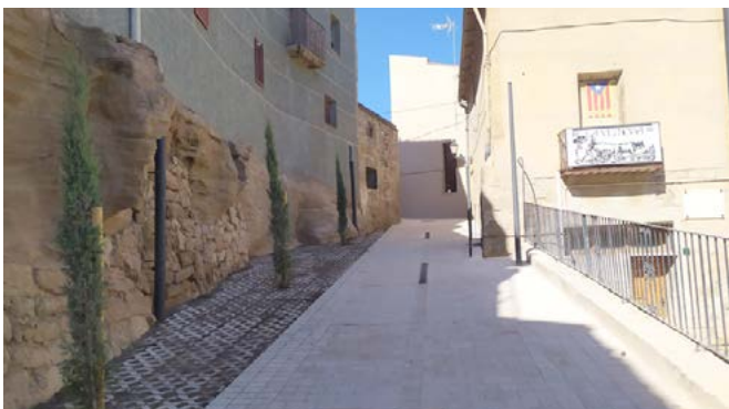
Obres de la Vileta
