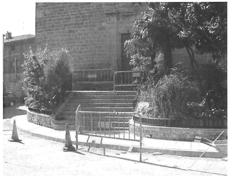
Obres a la Plaça de l'Església
