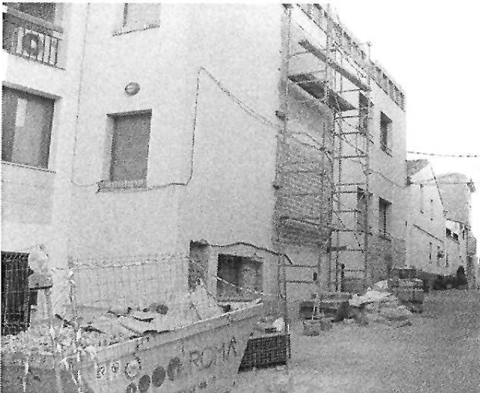
Obres de col·locació d'un ascensor a Casa de la Vila.
