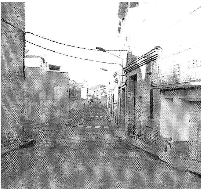
Nou paviment del carrer Mestre Ginera
