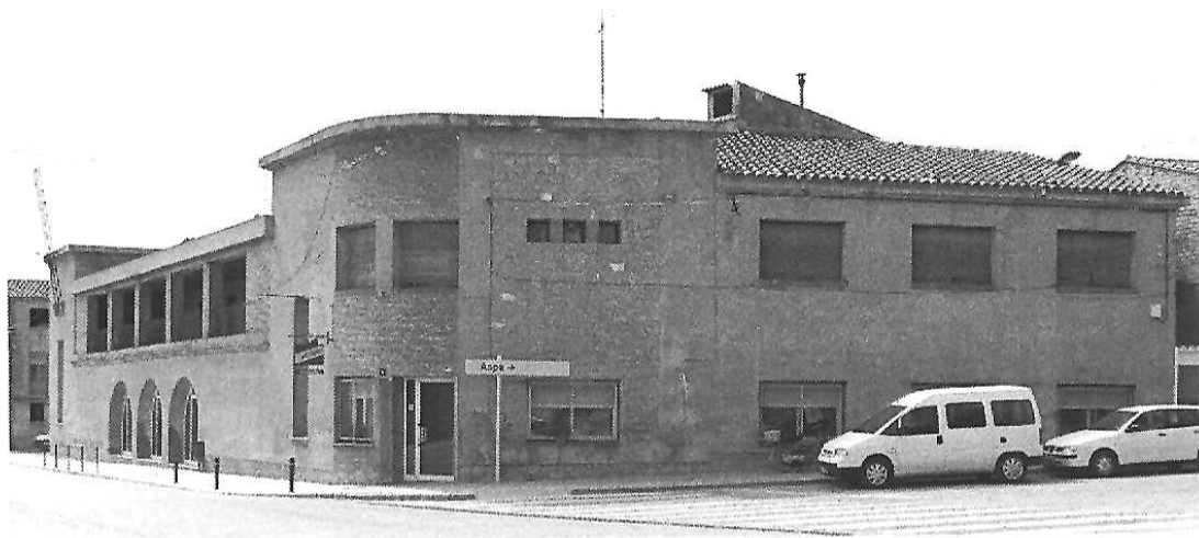
Aviat s'iniciarà la darrera fase d'obres a La Llar del Poble
