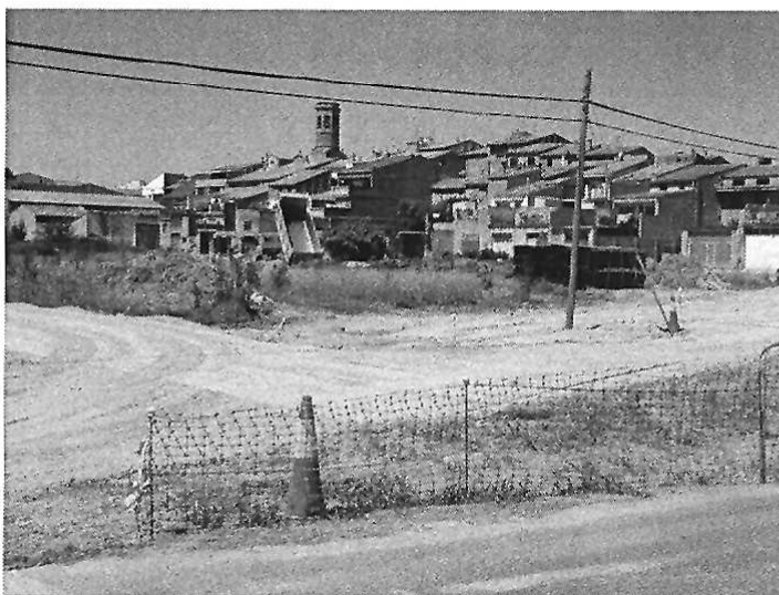
Obres d'urbanització a la UA4
