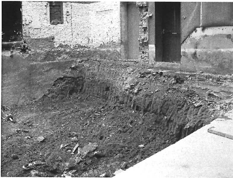
Obres de la Llar del Poble
