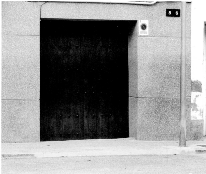
Instal·lació de guals
