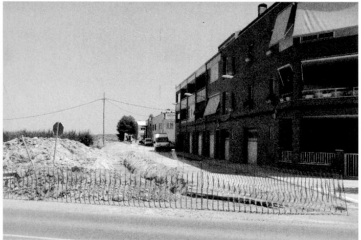
Obres al carrer Escoles
