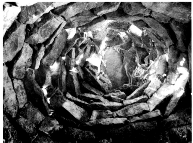
Coronament de la cabana de falsa cúpula
