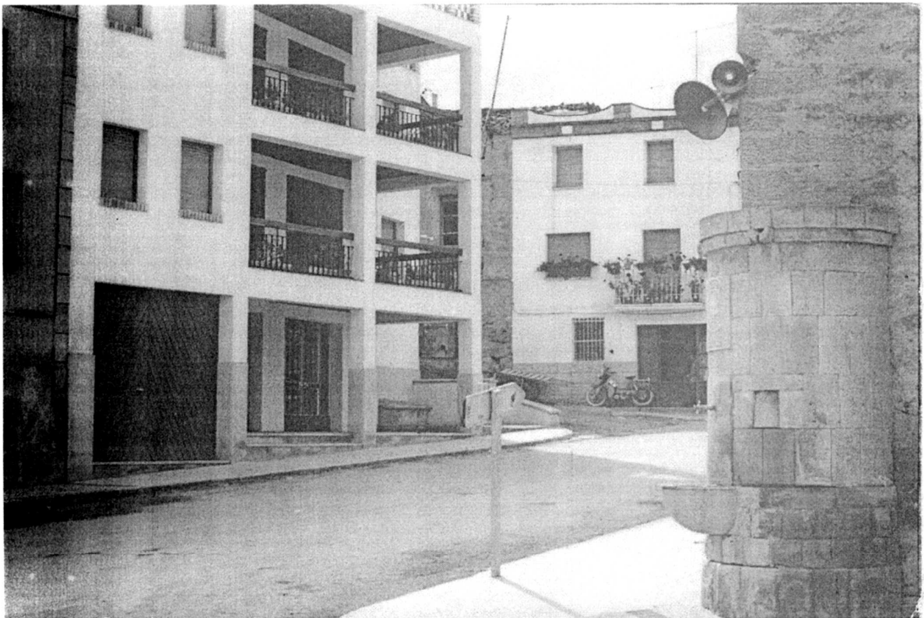
La font en forma de torre de la cantonada de cal Pelat
