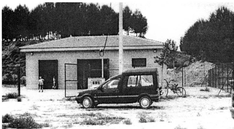
Aspecte exterior de la planta potabilitzadora
