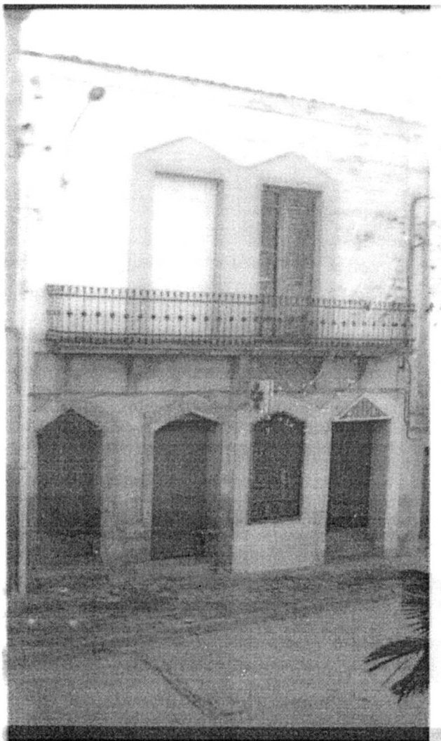
Façana principal del Sindicat de Sant Isidre, al carrer dels Gallart, tal com està en l'actualitat
