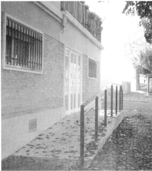
Obres de supressió de barreres arquitectòniques al consultori mèdic
