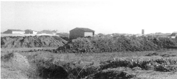
Urbanització del SAU R2, darrera del Raval de la Sra. Victòria
