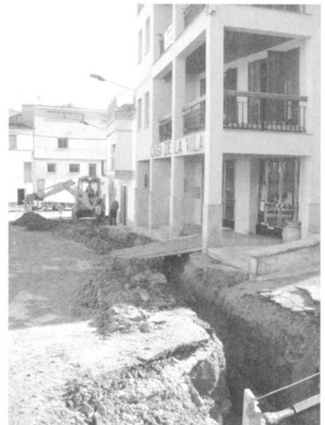
Obres al carrer Castell
