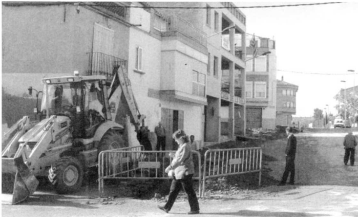
Obres al carrer Castell
