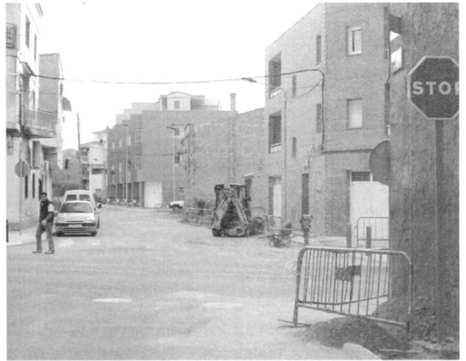
Obres al carrer les Hortes
