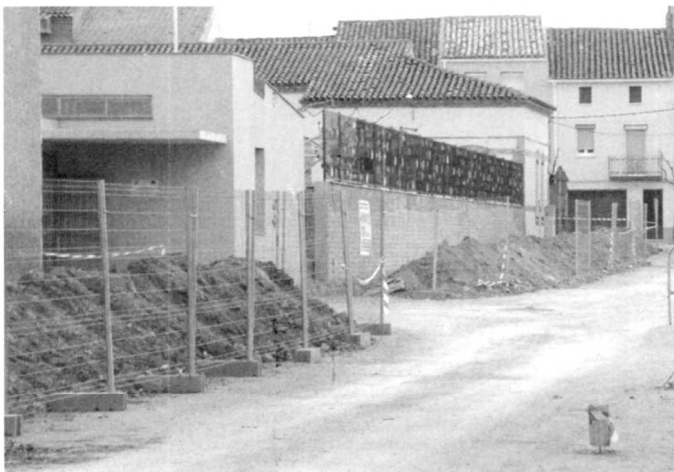
Obres al carrer les Escoles
