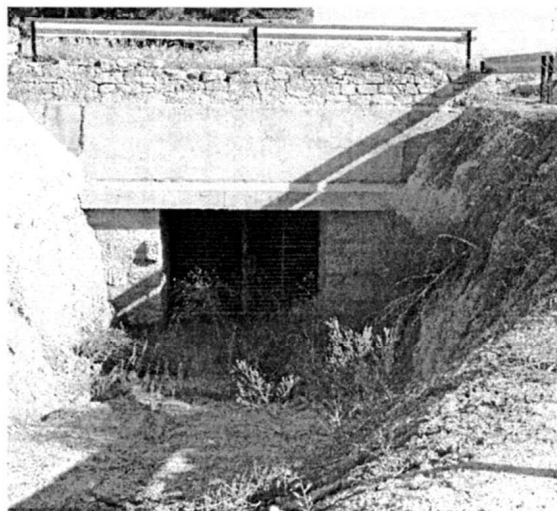
Nova entrada al dipòsit vell
