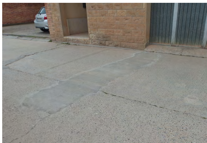
Reparació del paviment del carrer Raval de la senyora Victòria
