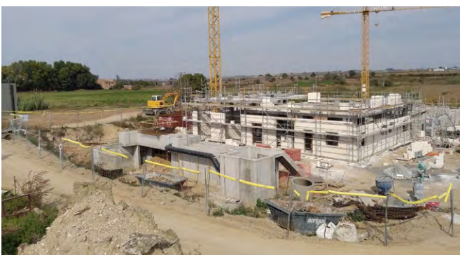
Continuen les obres de la depuradora
