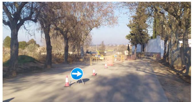
Obres de la depuradora
