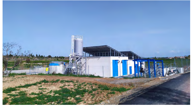
Acabades les obres de la depuradora
