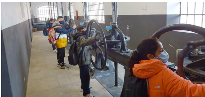
Sala de control de les comportes
