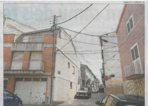
Els cables elèctrics d'un dels carrers afectats.
