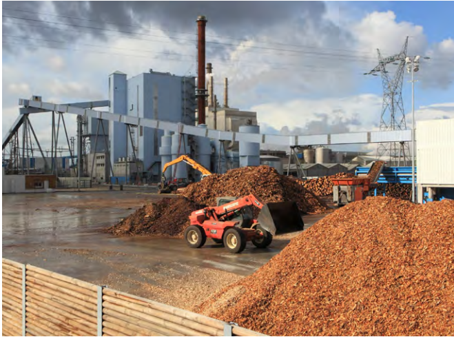
Central tèrmica de biomassa
