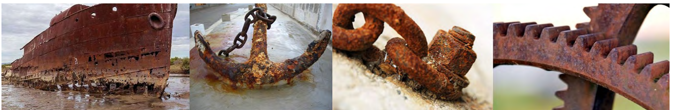
Figura 1: Efectes de la corrosió. En contacte amb medis químicament agressius apareixen els fenòmens corrosius en gran part dels aliatges metàl·lics, fet que indueix la degradació completa o parcial de les seves propietats mecàniques i, doncs, impossibilita el seu ús.
